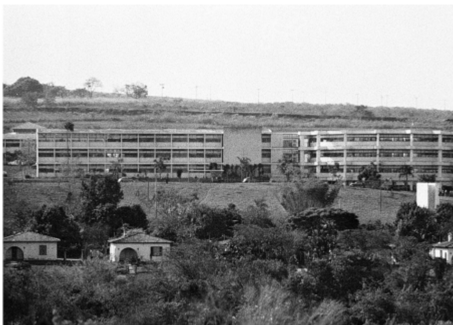
Bloco “A” e Edifício das Clínicas
