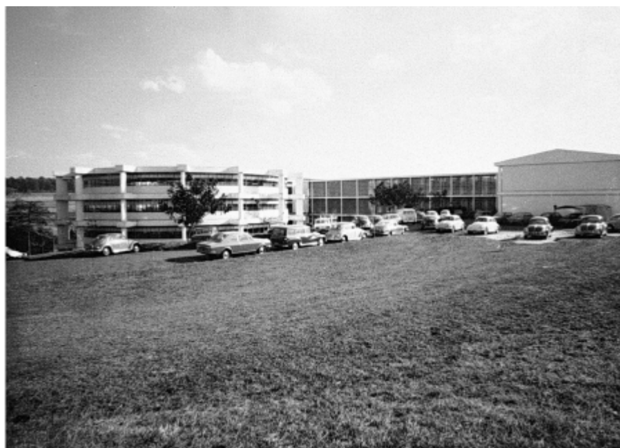
Edifício das Clínicas, passarelas e bloco “D”
